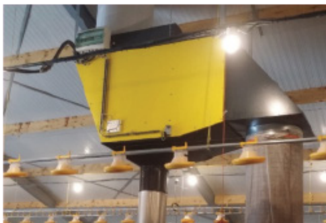
Granovi warmtewisselaar met absoluutfilter en recirculatie Foto: WLR
